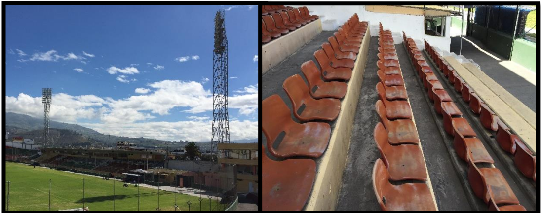
Fotografía N. 6 Tribuna del Estadio Bellavista desde el interior 2015
