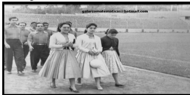
Fotografía N. 3 Estadio Bellavista vista interior año 1959
