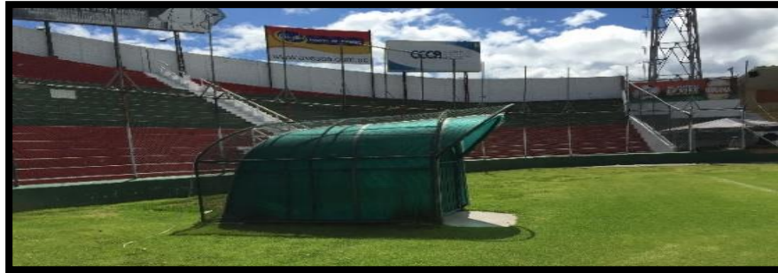
Fotografía N. 4 Estadio Bellavista vista interior año 2015
