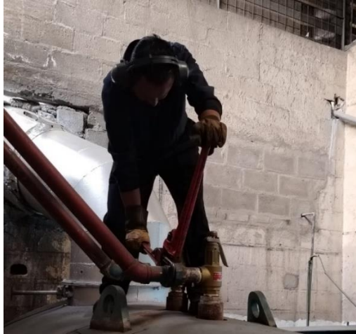
Imagen 25 Cambio de válvulas de seguridad y válvula check
