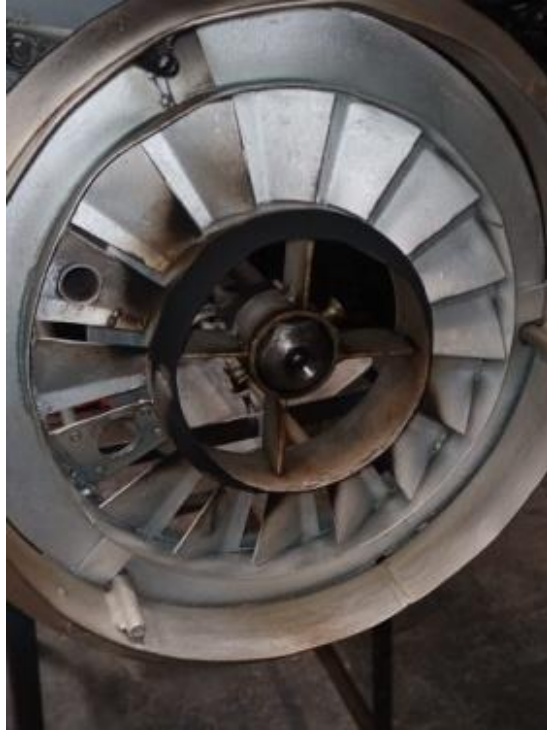
Imagen 28 Reparación del difusor de llama Fuente: Edison Espinoza
