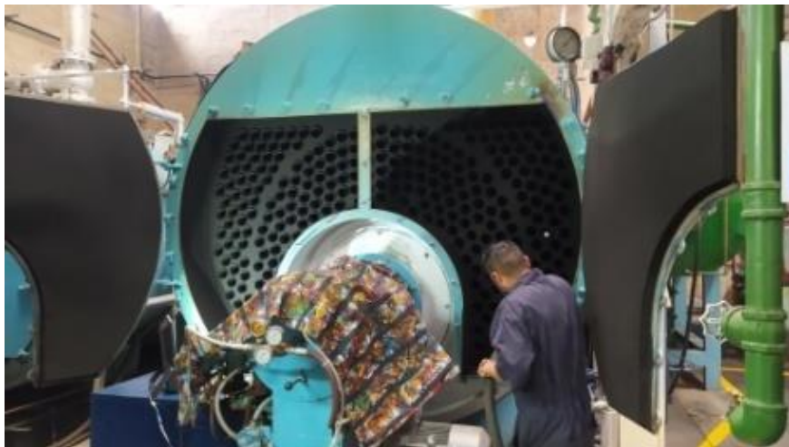
Imagen 22 Limpieza de tubos y cámara cilíndrica
