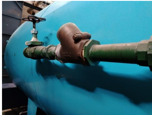
Imagen 26 Cambio de válvula check
