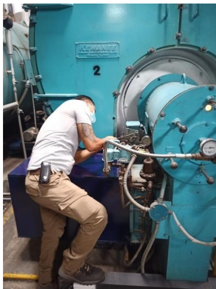
Imagen 32 Calibración de gases realizada por Retena S.A
