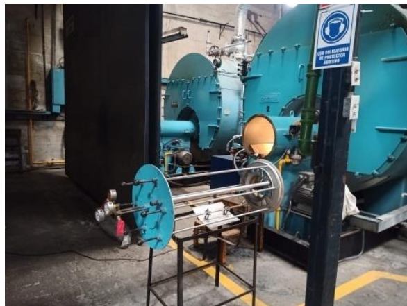
Imagen 27 Reparación del quemador caldero Kewanee
