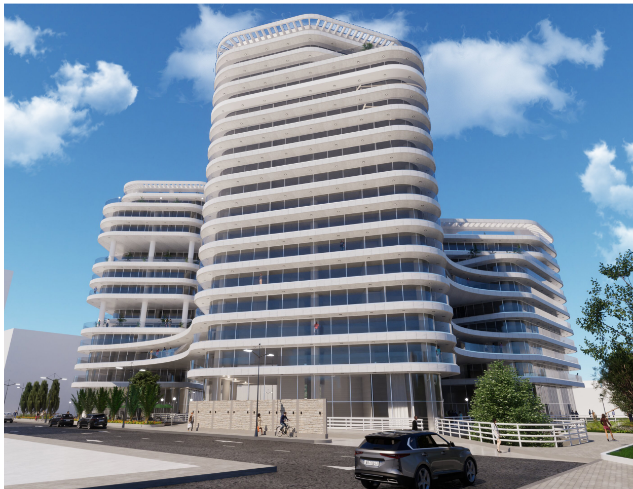
Figura 78. Vista desde locales comerciales Fuente: Elaboración propia (2024)
