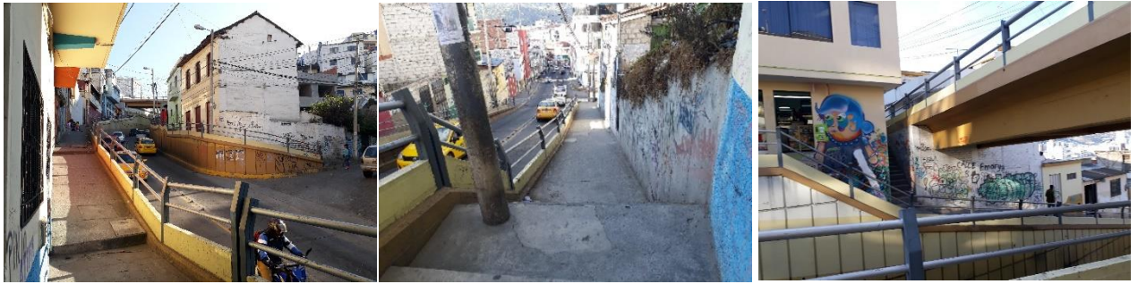
Imagen 7 Estado actual del “Viaducto la Yahuira”
