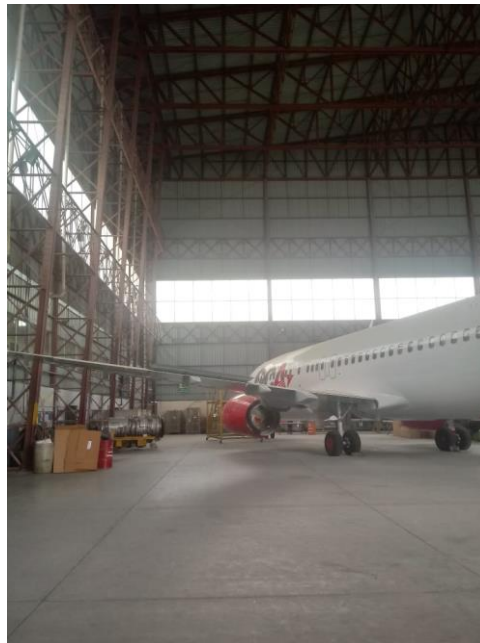
Imagen 10: Estructuras principales del hangar.
