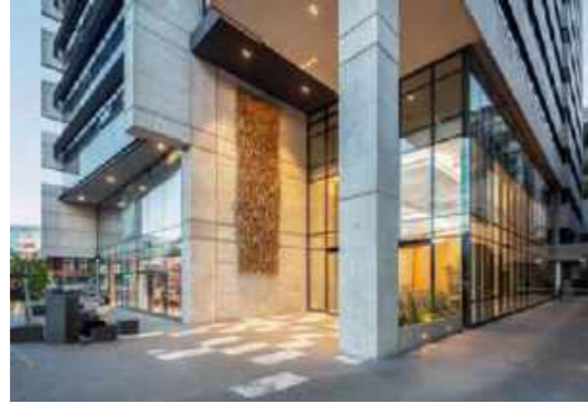
Imagen 7.Exteriores de Torre seis/diez.
