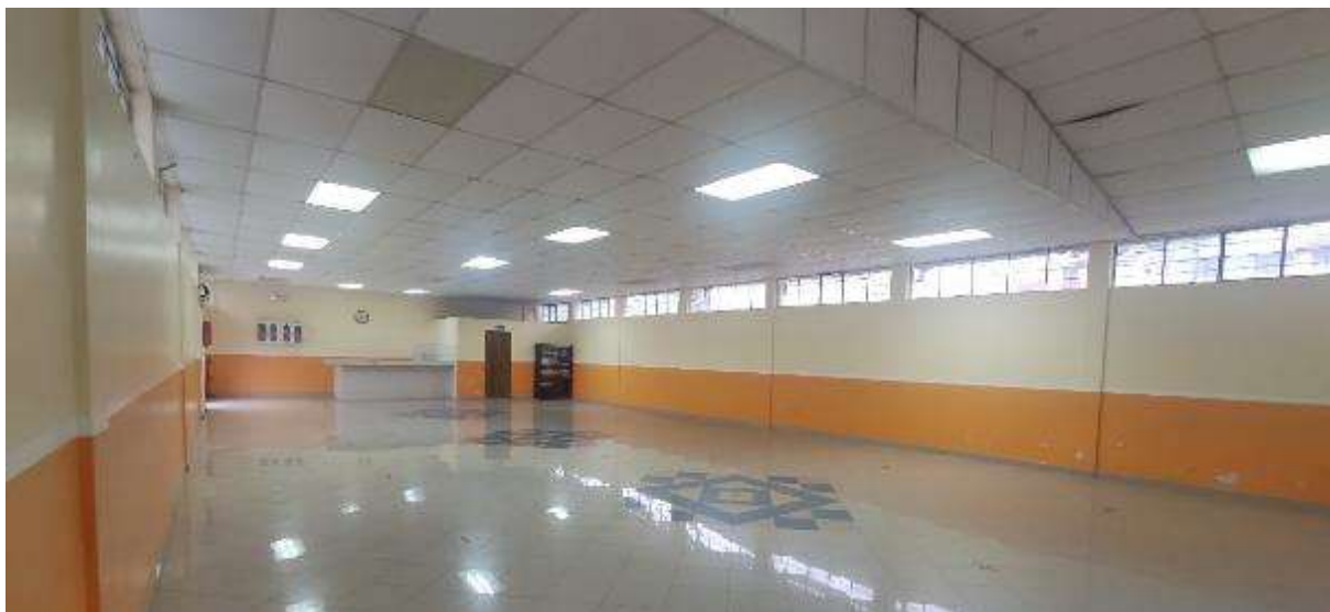
Ilustración 78: Renovación espacio Interior de la casa comunal Smz C año 2023. Fuente: Carrasco P. 2023
