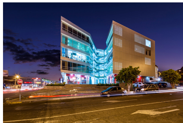
Figura 8. Edificio de uso mixto en Quito Fuente: Crespo, S-redfundamentos (2016)
