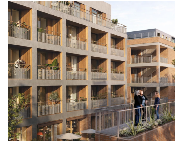
Figura 23. Edificaciones de mediana altura y vivienda colectiva
