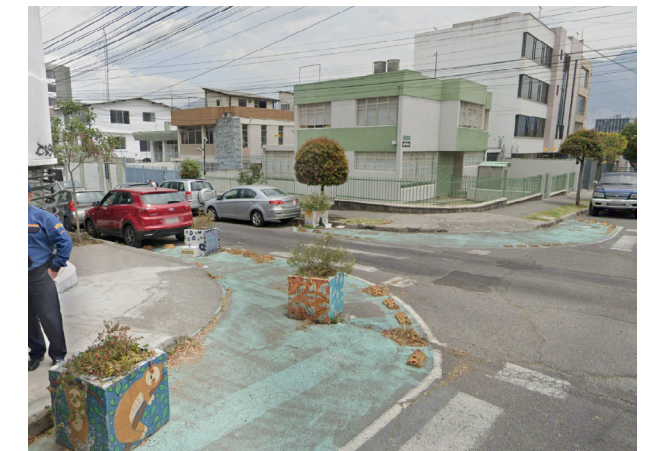
Figura 47. Deterioro de mobiliario urbano
