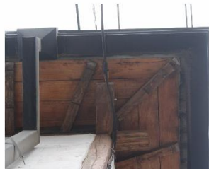
⑤ Cielo raso de Madera Cubierta tejada a cuatro aguas
