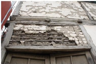
④ Detalle constructivo de bahareque
