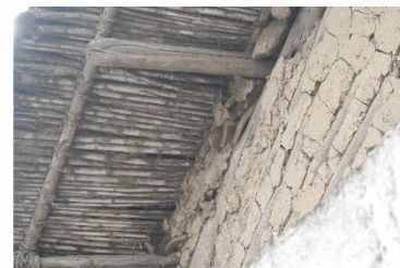
③ Cubierta, entramado de carrizo
