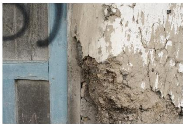
① Puerta principal de madera Muro portante, adobe
