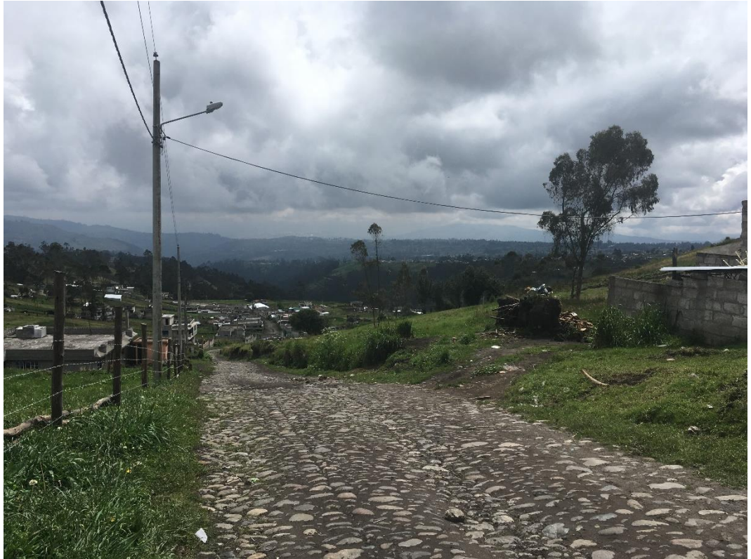
Fotografía 30: Vías colectoras Fuente: Tomada por Karen Elizabeth Arias Cáceres
