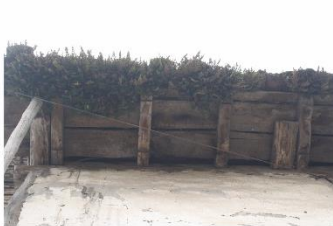
⑤ Cielo raso de Madera Cubierta tejada a dos aguas
