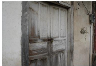
② Estructura y puerta de madera
