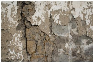
④ Muro de adobe - Muro de piedra
