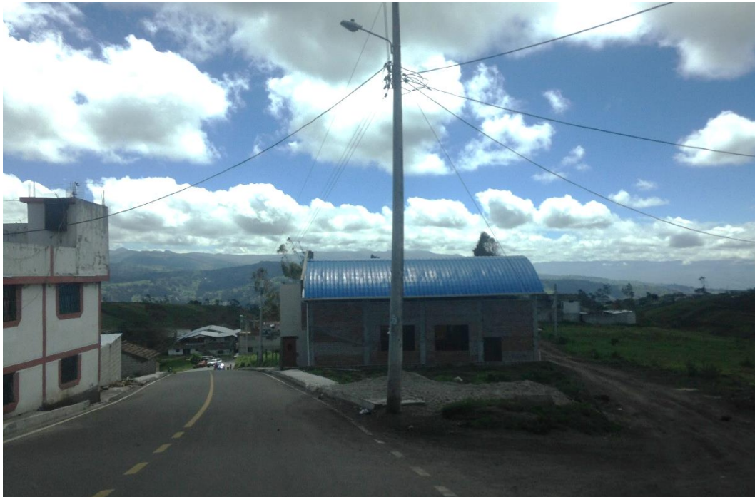
Fotografía 29: Vías colectoras Fuente: Tomada por Karen Elizabeth Arias Cáceres
