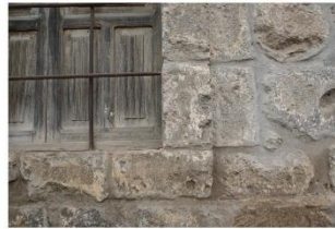
Barros de acero añadidos a las ventanas
