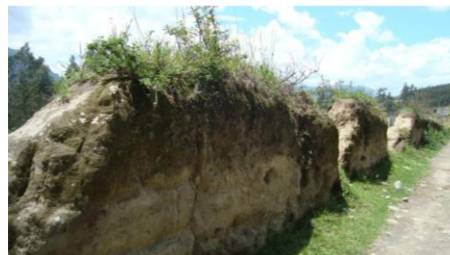
Fotografía 14. Muro de tapial.
