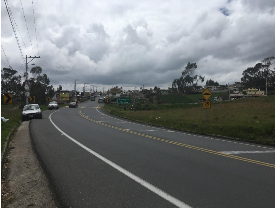
Fotografía 28: Vías colectoras Fuente: Tomada por Karen Elizabeth Arias Cáceres
