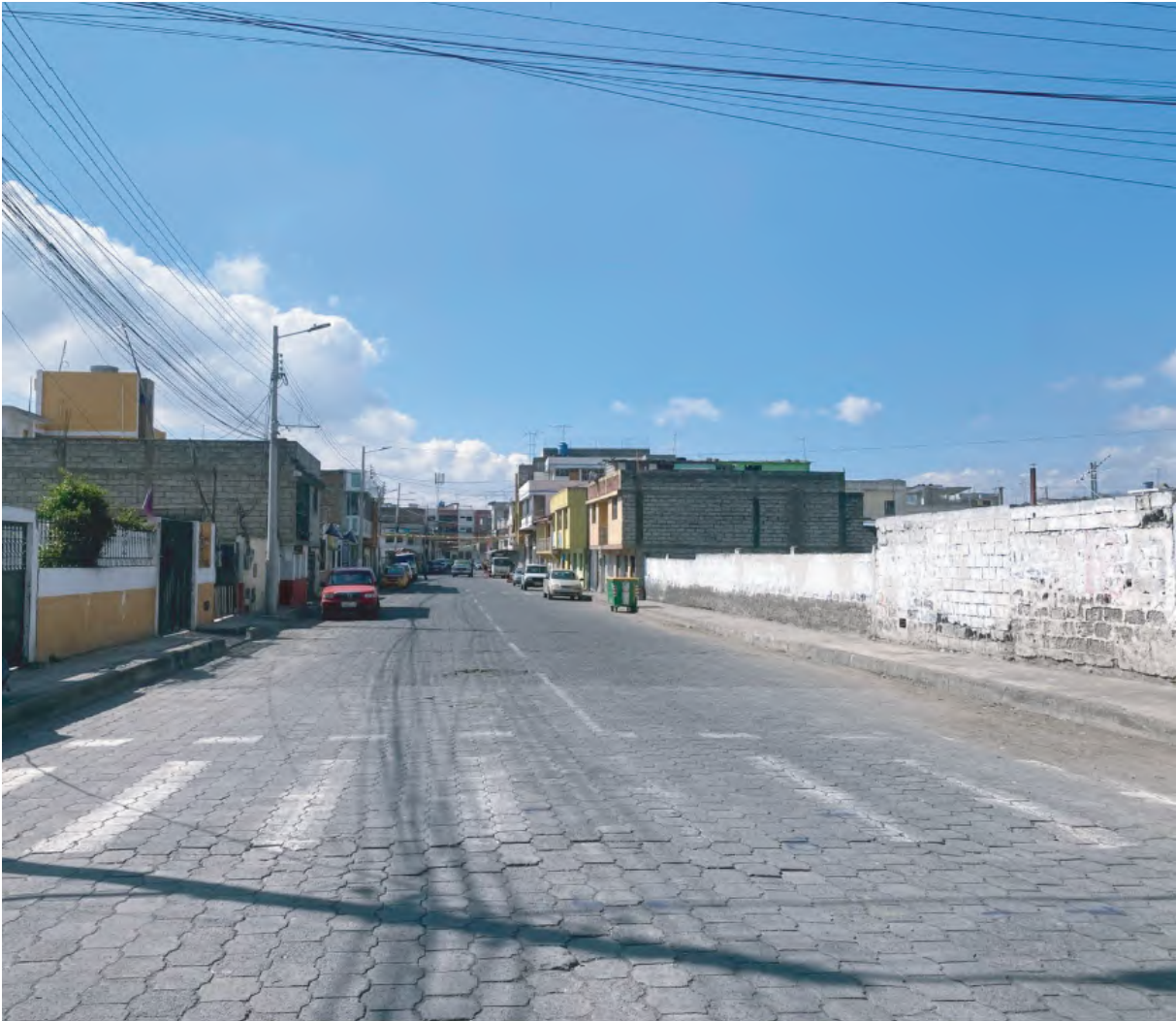
Figura 25. Aceras de la calle Bolivar - Antes
