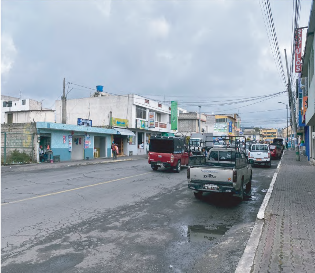
Figura 18. Vía Saquisilí tramo 2 - Antes
