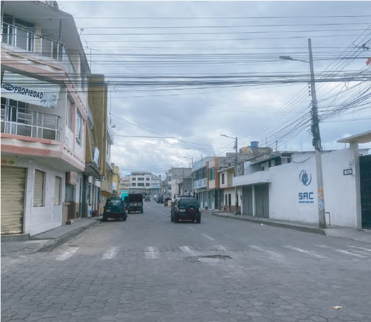
Figura 49. Mantenimiento de la vía Saquisilí, tramo dos, eliminación de baches y grietas - Después
