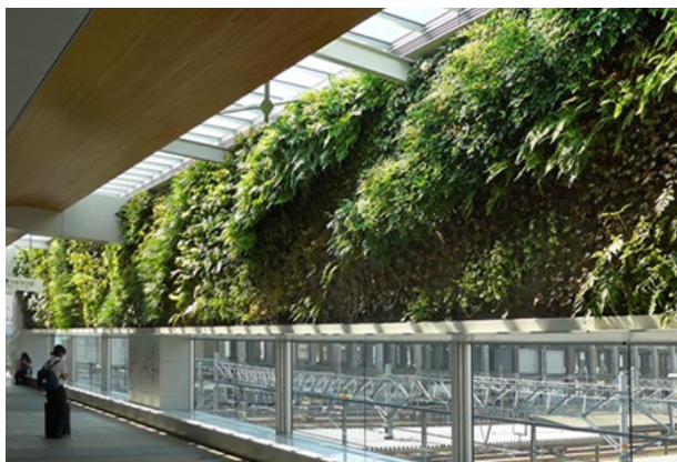
Figura 19. Fachada verde Intensiva. Square Vinet en Burdeos.
