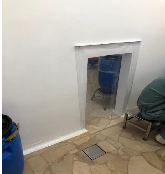
Figura 22: Abertura en el área de encapsulado y desinfección de cápsulas
