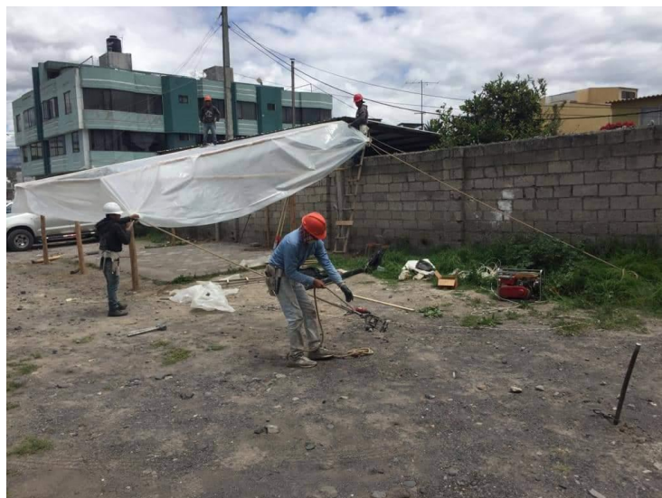
Ilustración 7: Colocación y tensado del plástico de polietileno Fuente: (Cedal S.A.)
