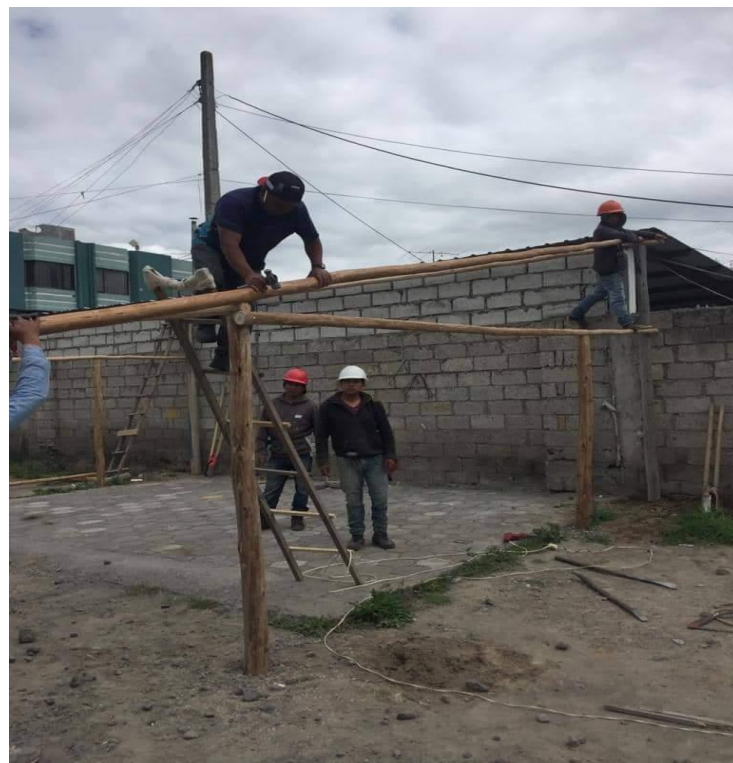
Ilustración 6: Colocación de los travesaños Fuente: (Cedal S.A.)
