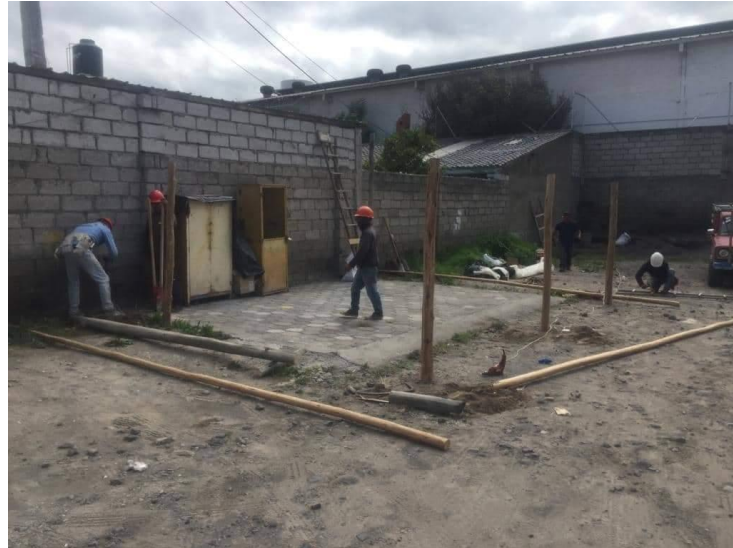
Ilustración 5: Colocación de los parantes Fuente: (Cedal S.A.)
