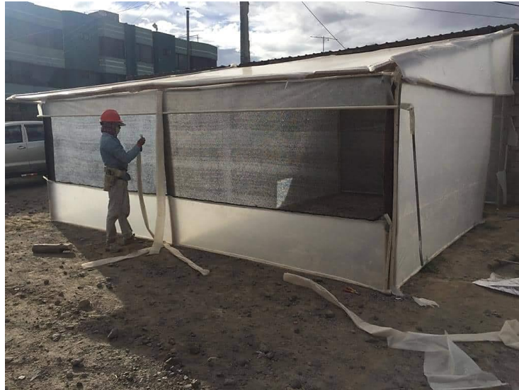
Ilustración 9: Colocación de las correas guías de la cortina Fuente: (Cedal S.A.)
