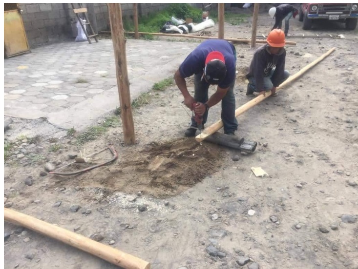
Ilustración 4: Construcción de la cámara de efecto invernadero Fuente: (Cedal S.A.)
