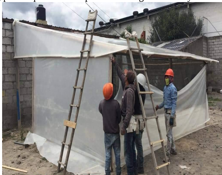
Ilustración 8: Colocación de la malla sarán y cortina Fuente: (Cedal S.A.)
