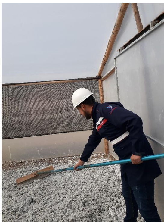
Ilustración 12: Remoción de los lodos Fuente: (Cedal S.A.)
