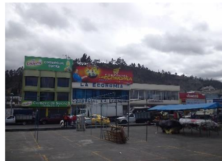
Imagen 31: Fachada Oeste FUENTE: Propia
