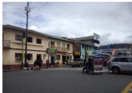
Imagen 29: Fachada Sur FUENTE: Propia
