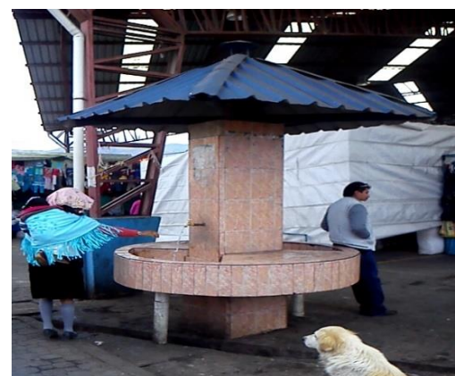
Imagen 4: Bebedero publico deteriorado FUENTE: Elaboración Propia
