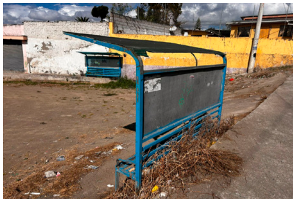
Figura 57. Fotografía estado actual sin rampas ni señalética
