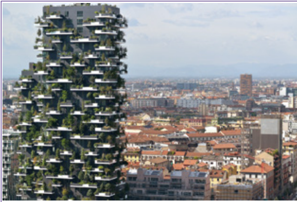
Imagen 5 Título: Bosco Verticale Fuente: Plataforma de Arquitectura, 2015
