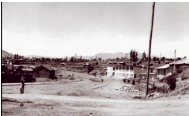
Inicios de la construcción del edificio central del Municipio de Pelileo
