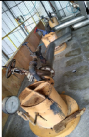
Válvulas de despresurización.
