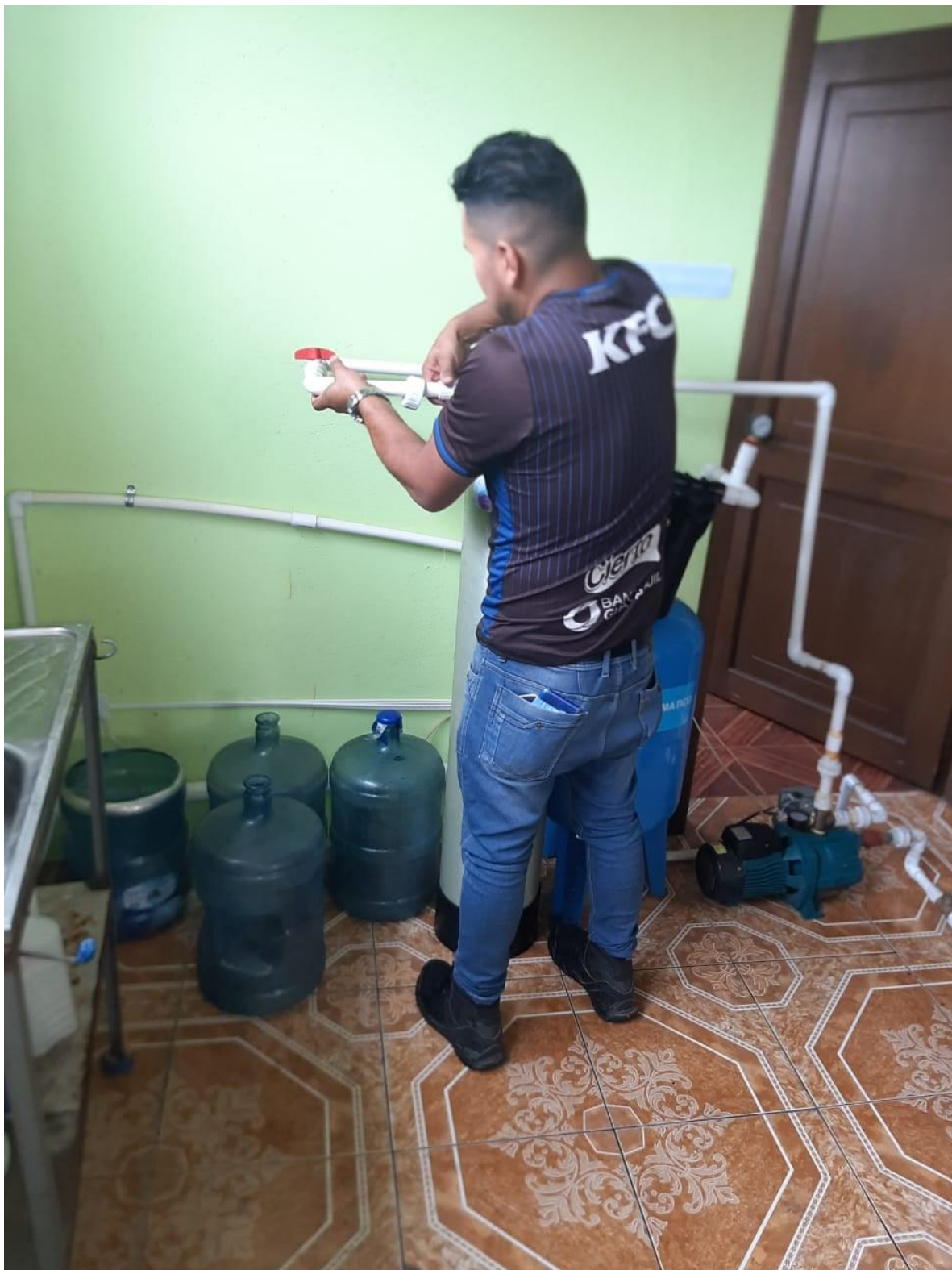
Anexo 9.- Instalación de tuberías para el proceso de limpieza de bidones de 20 litros.
