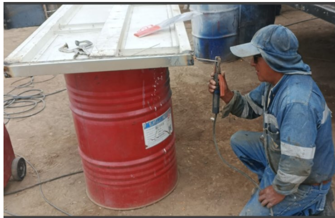
Imagen 5. Suelda de estructura.
