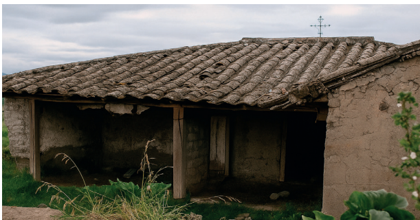
Figura 5. Abandono de viviendas vernáculas
