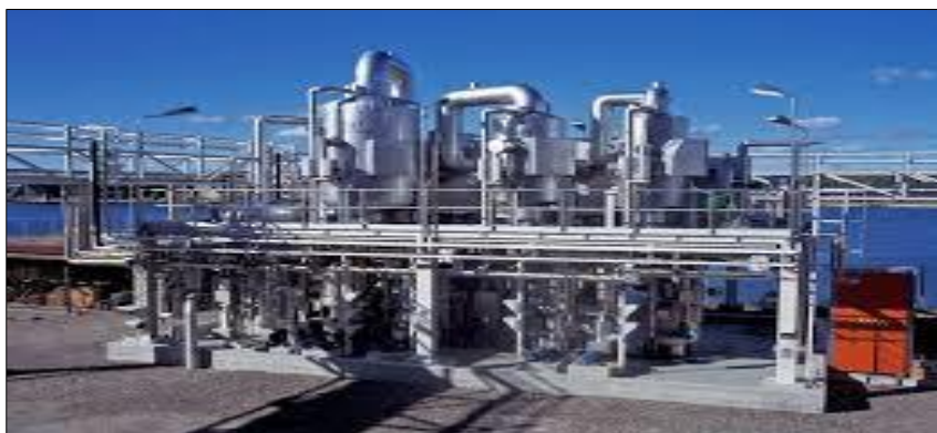
Gráfico 26: Instalaciones de la Empresa INTERQUIMEC S.A.
