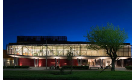
Figura 11. Edificio Centro Cultural Arauco
