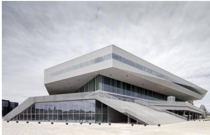
Imagen 30. Biblioteca Dokki Fuente: Plataforma Arquitectura
