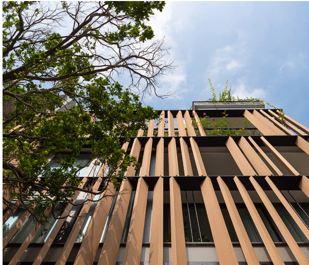
Figura 20. Protección Solar Vertical, Fachada con lamas de madera en LH House
