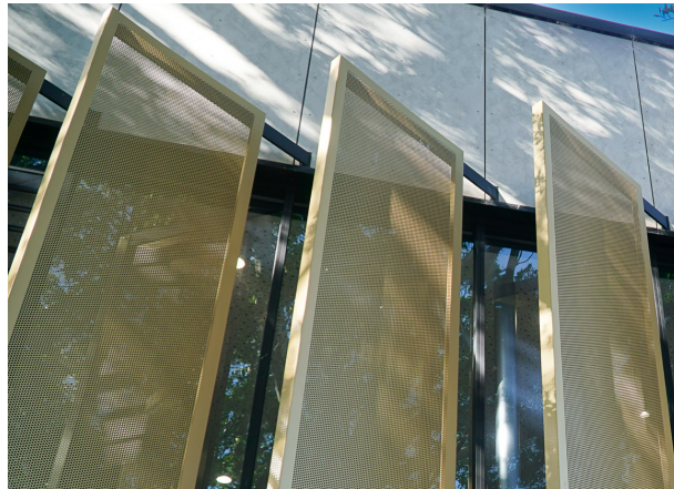
Figura 28. Fachada de la escuela Canterbury South Public School con paneles perforados.
