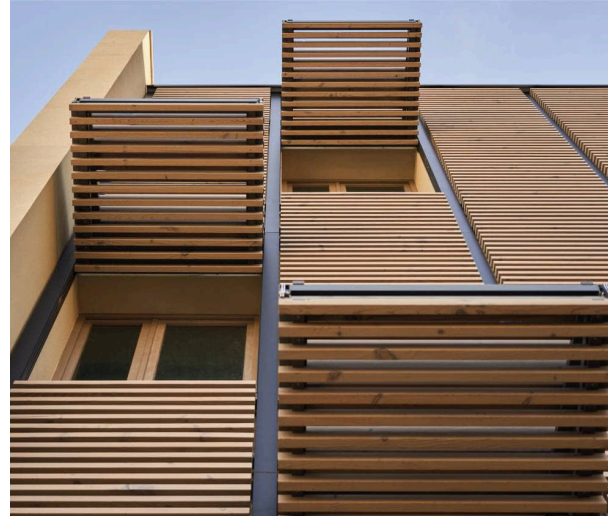
Figura 21. Protección Solar Horizontal, Celosía móvil de madera en fachada
