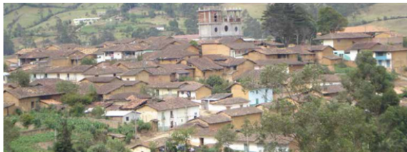
Figura 3 Construcciones en Tierra en Ecuador
