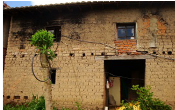
Figura 12 Construcción en Tierra
