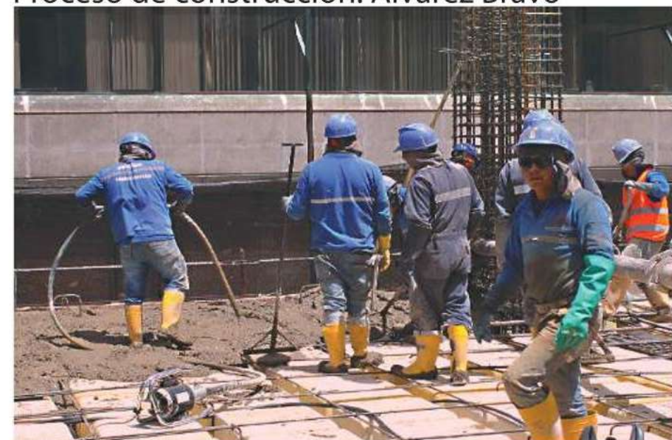
Proceso de construcción: Álvarez Bravo
