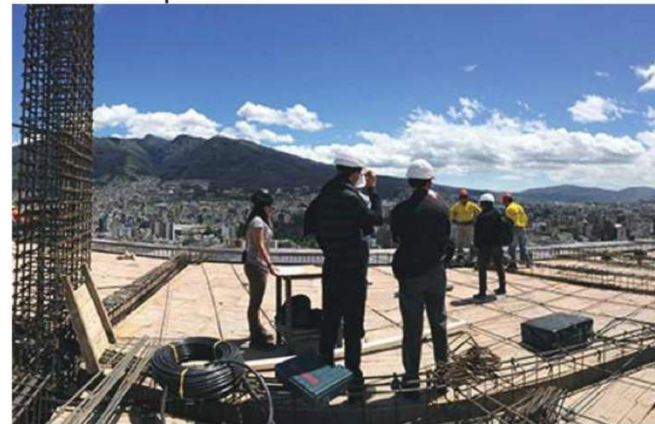
Proceso de construcción: Álvarez Bravo
