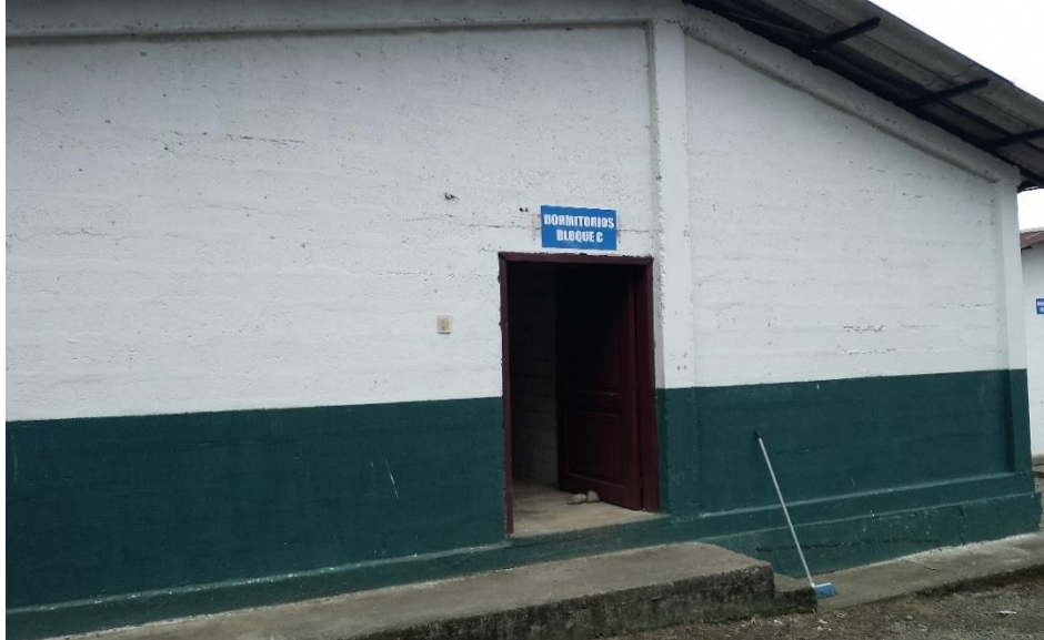
Imagen 11. Dormitorios bloque C
