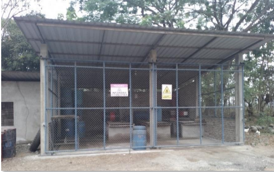
Imagen 5. Almacenamiento de combustible
