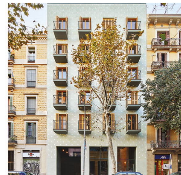
Figura 19. Exterior del proyecto 110 Rooms.
