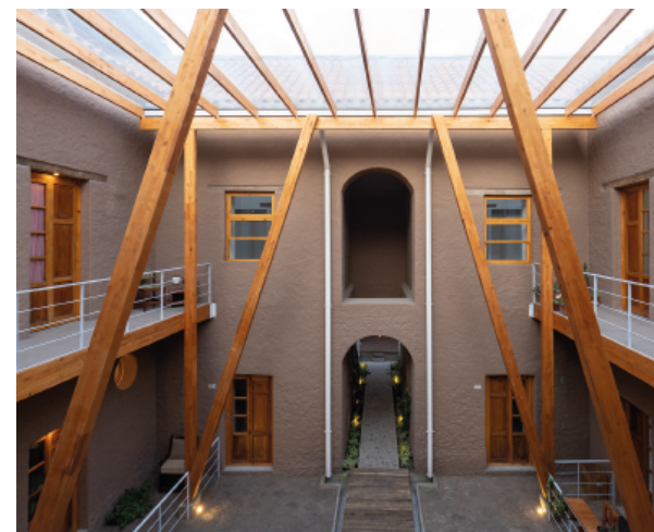
Figura 18. Estructura mixta madera-acero.
