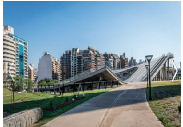
Figura 50. Vista exterior del proyecto.
