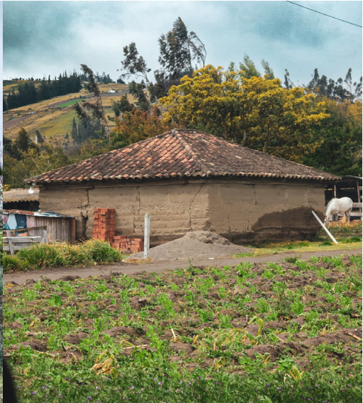
Figura O7. casa de tapial cuarteada Salasaka Nota. elaborado por Angie Lopez (2025)
