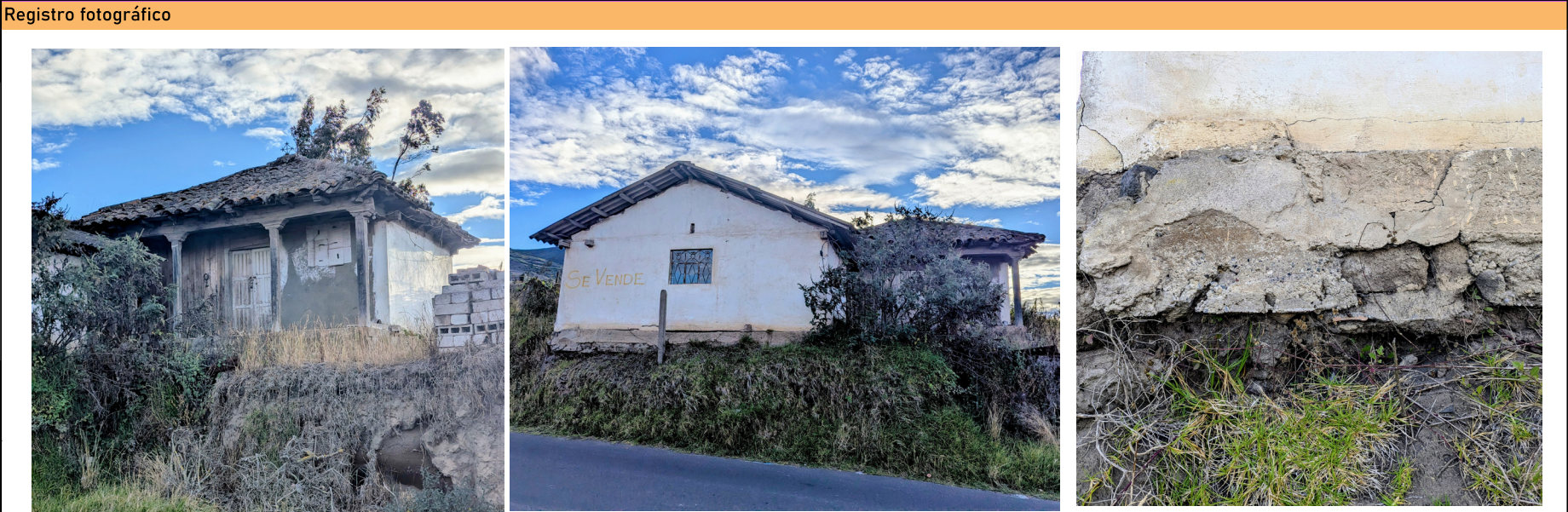
Vivienda de tapial con cubierta de paja
