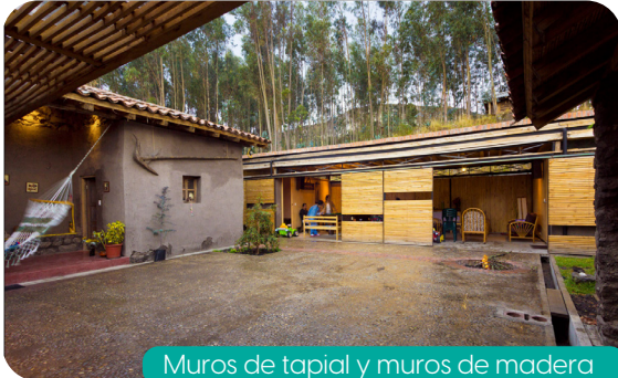
Muros de tapial y muros de madera
