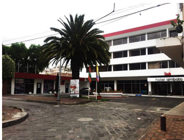
Imagen 81.- Hotel Ambato en la actualidad, antiguo lugar donde se ubicó el Rastro.
