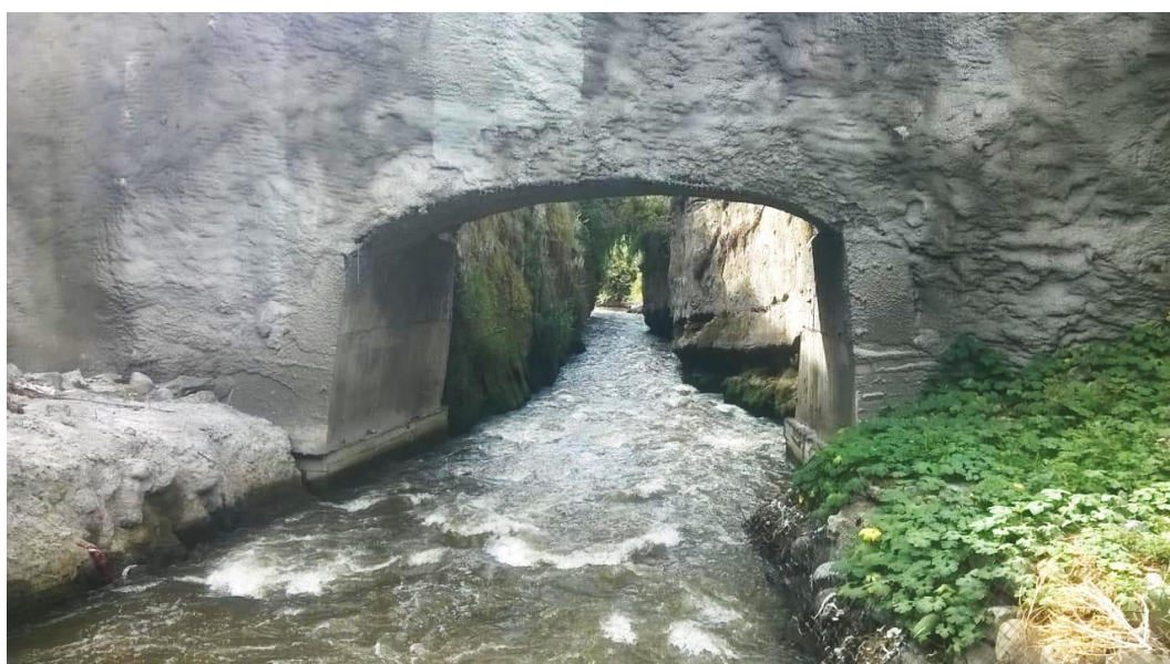
Imagen 17.- Puente Camino Inca, actualmente modificado y recubierto por hormigón soplado.
