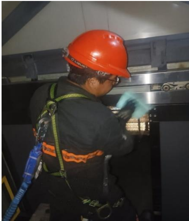
Figura 7 Personal utilizando Equipos de protección en el desarrollo de sus actividades 3
