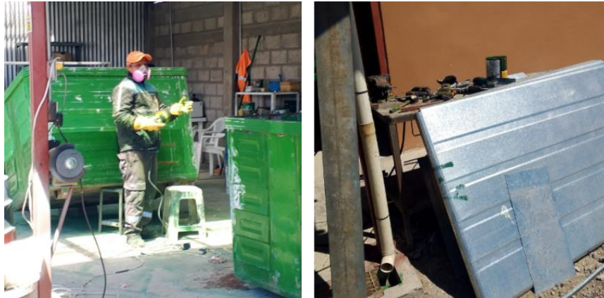
Imagen 5. Preparación de materiales Elaborador por: GTM S.A., (2025).
