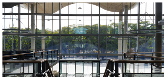
Figura 18. Forjado translucido en fachada Fuente: Alejandro Levaratto, 2015
