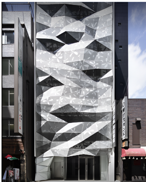
Figura 17. Fachada frontal edificio de oficinas Fuente: Nacasa & Partners Inc, 2013
