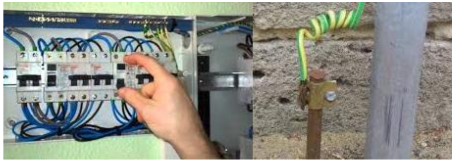
Figura 45: Conexión tierra tablero
