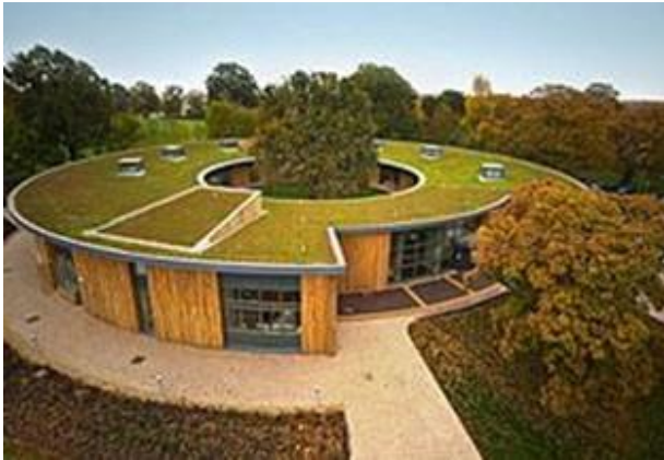
Figura 13. Techo verde de la central de la British Horse Society
