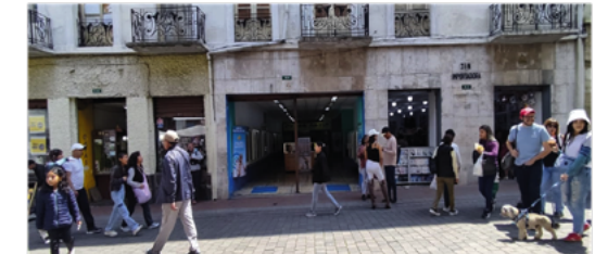
Fachada calle Venezuela
