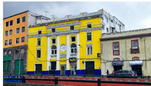
Figura 13. Tuti en edificación patrimonial.
