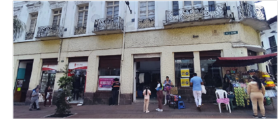
Fachada calle Sucre
