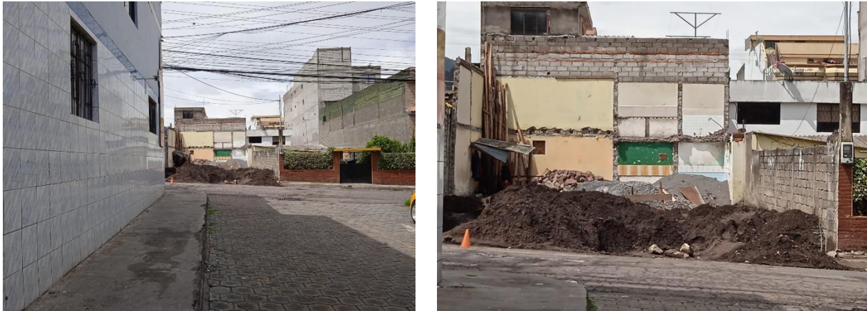
Figura 28 Tercer piso/ Vivienda unifamiliar construida
