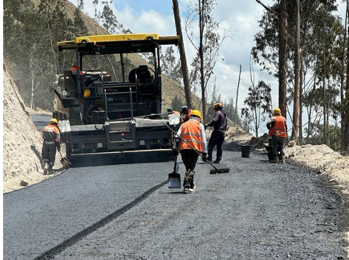
Imagen 1. Colocación de asfalto en obra Fuente: Pazmiño, Linda (2024)
