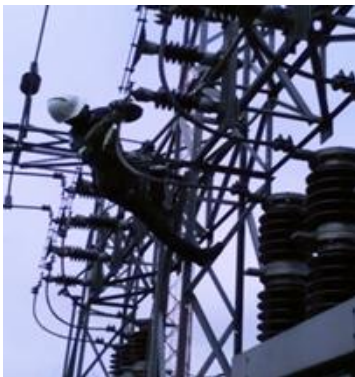
Figura 4 Trabajadores realizando trabajos sin el uso de protección personal
