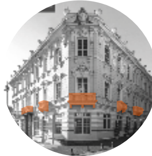
Figura 206. Materialidad Casa Gangotena
