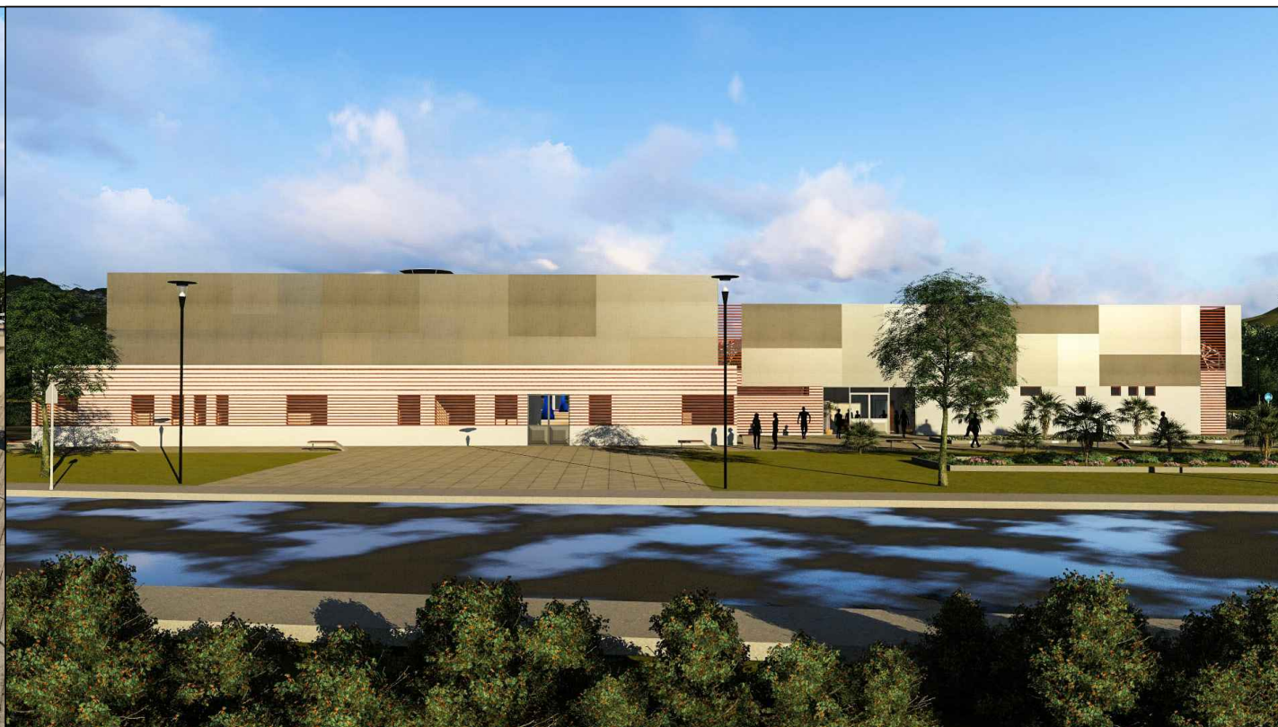
VISTA EXTERIOR S/E
