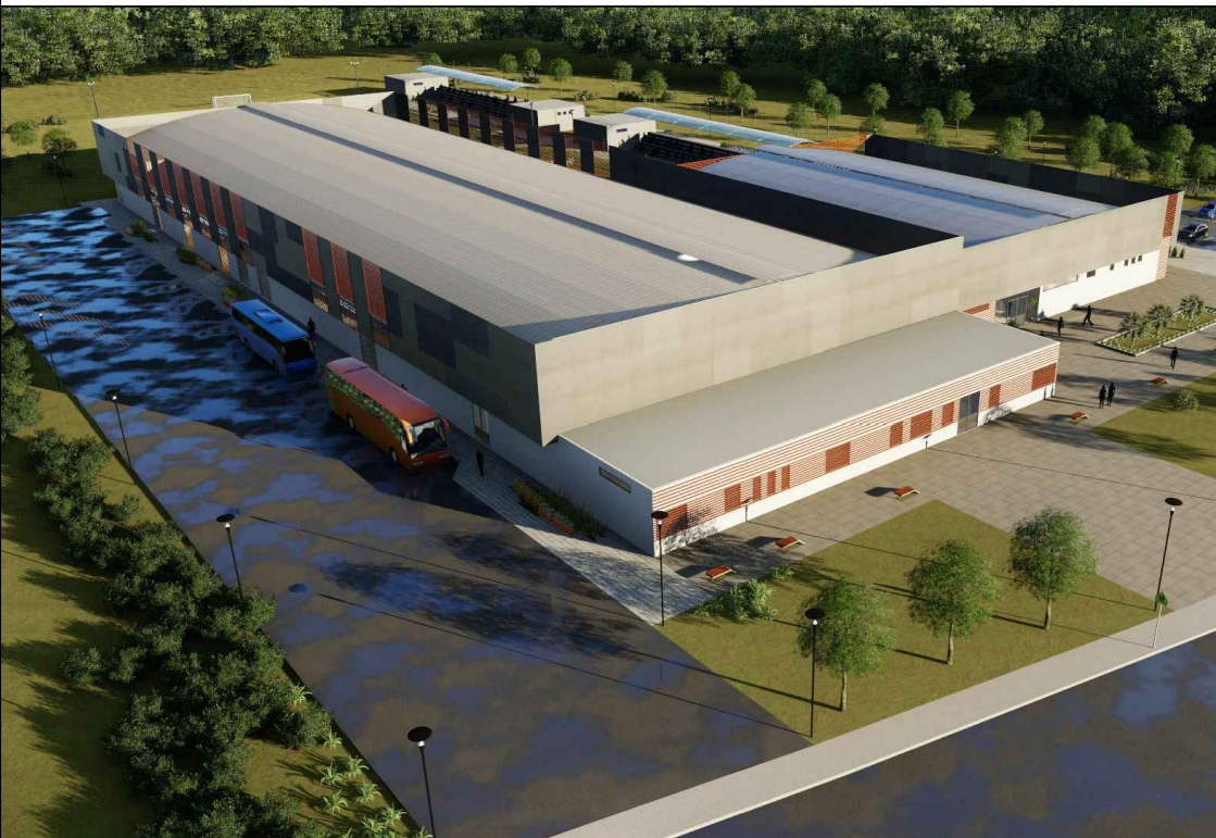
VISTA EXTERIOR S/E
