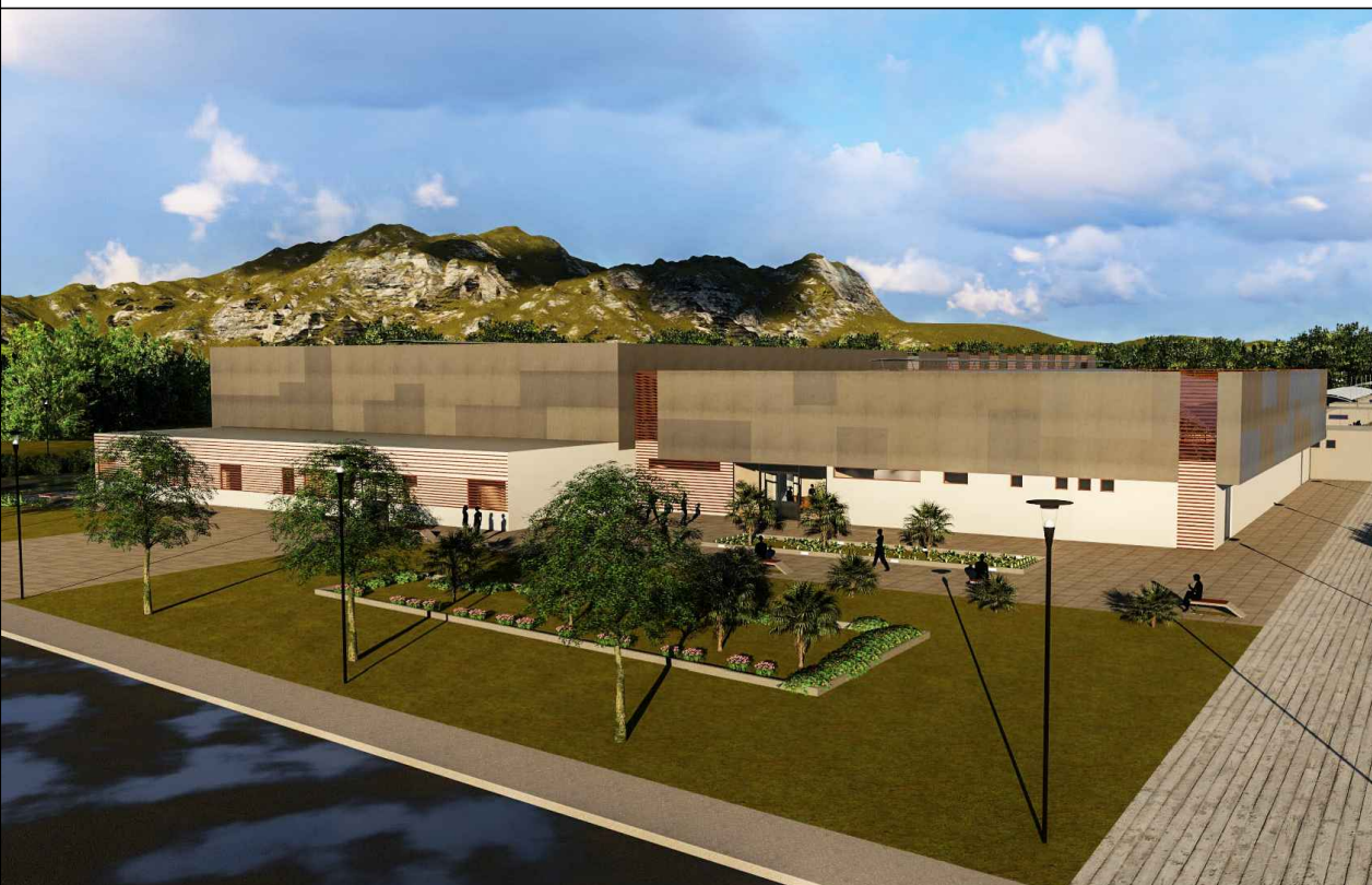
VISTA EXTERIOR S/E
