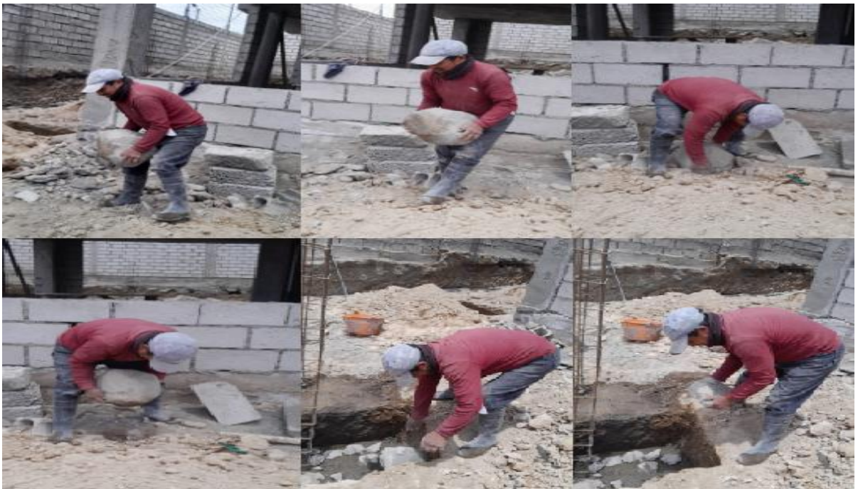
Anexo 4. Recopilación de fotografías para la evaluación del puesto del maestro albañil y ayudante de albañilería durante el traslado de materiales para la fundición de plintos y cimientos
