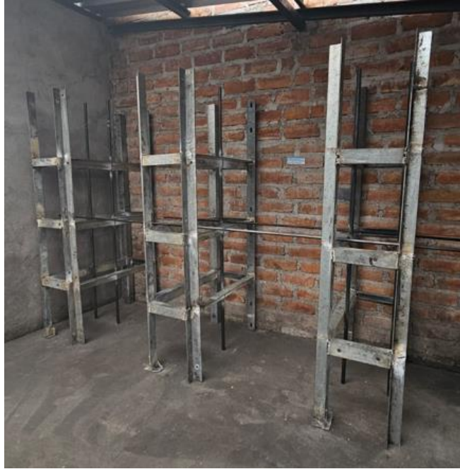
Imagen 15. Estructuras metálicas para ordenar varillas (Sección 1). Elaborado por: Muyulema, Alex (2024).
