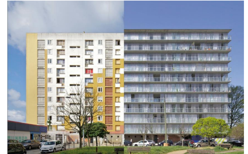
Imagen 2 Rehabilitación de bloques de viviendas de posguerra
