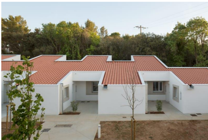
Imagen 27 Fotografía trasera de las viviendas.
