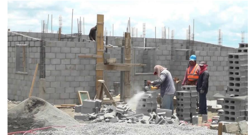
Imagen 42 Proceso de construcción de muros
