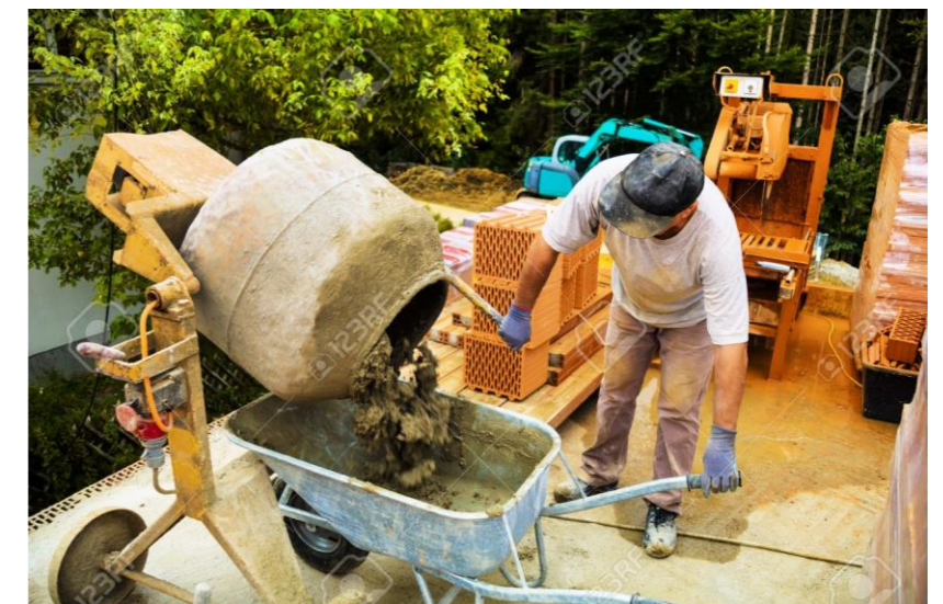
Imagen 43 Mezcladora de hormigón y materiales necesarios
