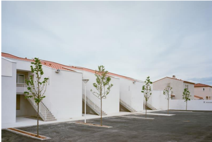
Imagen 26 Vista externa de las viviendas.
