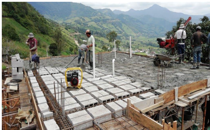
Imagen 44 Fundición de losa
