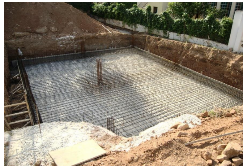
Imagen 413 Losa base de casa
