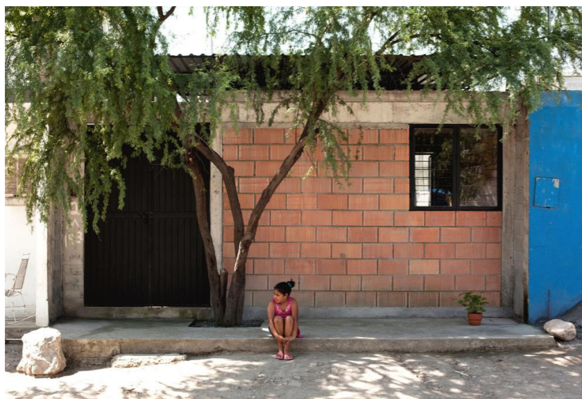
Imagen 7 Nuevas viviendas accesibles
