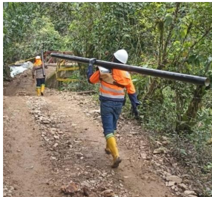
Imagen 3. Transporte manual de tubería. Elaborado por: GoldTech Drilling
