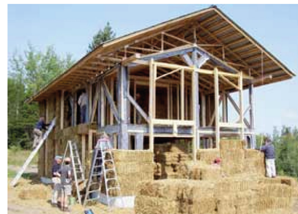
Figura 15. Tecnología apropiada casa de balas de paja con estructura post&beam
