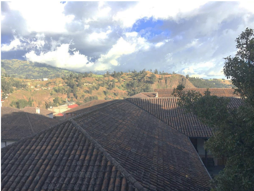
Imagen 21 Cubiertas de los bloques 3 y 5
