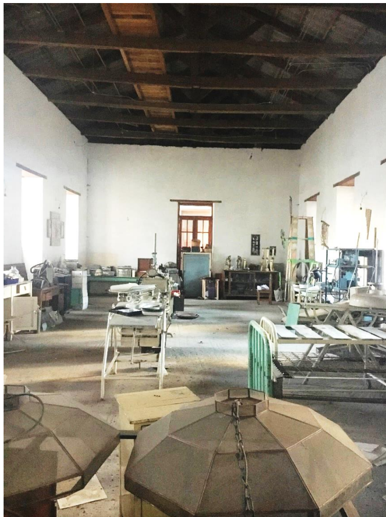
Imagen 22 Espacio interno del Bloque 5
