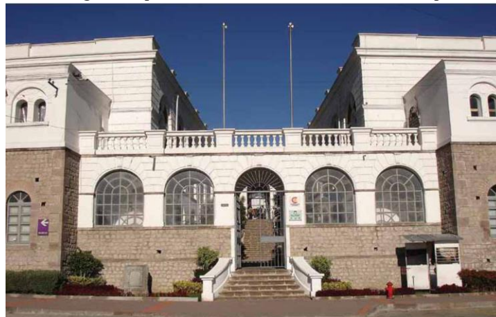
Imagen 2 Ingreso del Antiguo Hospital Militar en la ciudad de Quito, después de la intervención.
